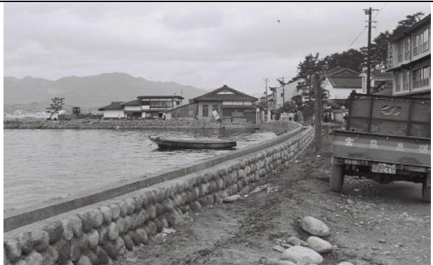
1959 年当時の有之浦（護岸工事をしているとき）
