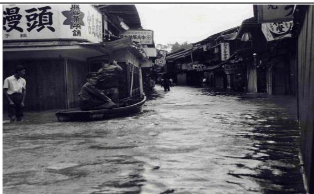
1959 年異常潮位により商店街浸水風景
